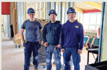
Chantier : École Chicoutimi Nord. Entrepreneur : Électrovolt. Travailleurs : Carl Simard, Charles-Antoine Fortin et Noa Brisson.
