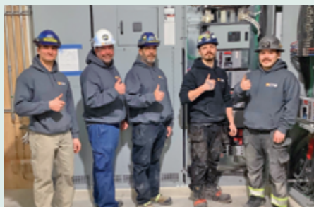
Chantier : Usine maisons préfabriquées Arviat, Nunavut. Entrepreneur : CMI. Contremaître : Stéphane Demers.
