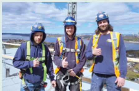
Chantier : Le Rinfret. Entrepreneur : Pierre Landry électrique. Travailleurs : Maxime Nicole, Josh Deschênes et Frédérik Fradette.
