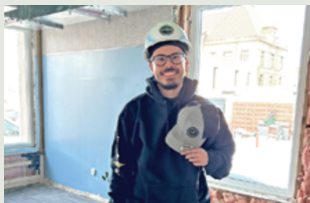
Chantier : Caisse populaire La Baie. Entrepreneur : Service énergétique M.T. Travailleur : Youry Prince.
