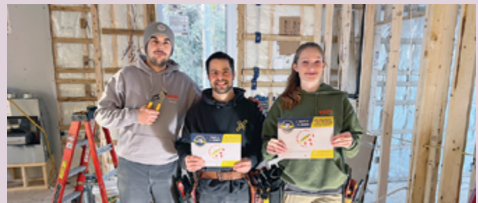
Chantier résidentiel Natura, à Bromont. Entrepreneur : Volta électrique. Les confrères Jonathan Duhaime (recevant les Channel lock pour son passage en 3 e année), Miguel Béliveau-Guay (contremaître), ainsi que la consœur Regan Fairholm.
