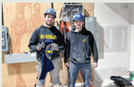
Chantier : Plaza centre-ville Alma. Entrepreneur : Rémi Bouchard électrique. Les confrères Charles Gilbert et Samuel Plourde.
