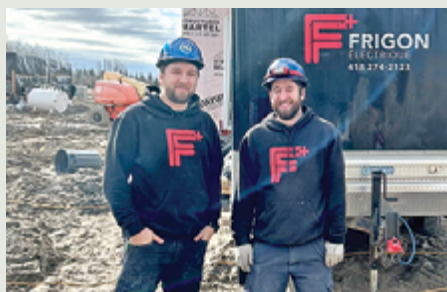
Chantier : Logements St-Félicien. Entrepreneur : Frigon électrique. Travailleurs : Jérémy Langlais et Jean-Francis Pagé.
