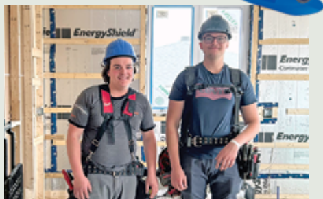
Chantier résidentiel, à Alma. Entrepreneur : Valmo. Travailleurs : Julien Gagné et Christopher Bouchard.
