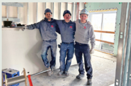
Chantier : Les Jardins St-Émile, à Jonquière. Entrepreneur : Boily électrique. Les confrères Samuel Racine, François-Xavier Lamothe et Vincent Boily.
