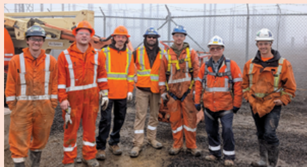
Travailleurs de lignes au poste MU, à Escuminac.
