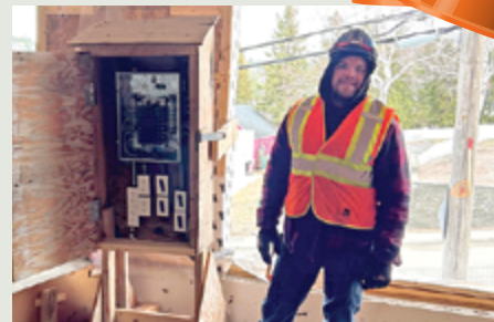
Chantier résidentiel de 80 logements, à Chicoutimi. Entrepreneur : Japi électrique. Travailleur : Alexandre Simard.
