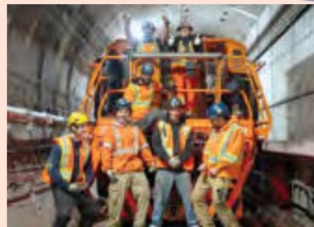
Travailleurs de lignes sur le chantier du REM, à Montréal.
