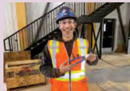
Le confrère Olivier Orellana, recevant les pinces d'électricien pour la réussite de son examen compagnon. Bravo ! Cie : IESD. Chantier : Bâtiment gestion des actifs ville de Bromont.
