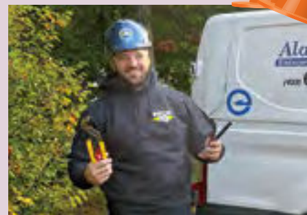
Le confrère Sylvain Robichaud, pour Alain Allard électrique, sur un chantier d'Hydro-Québec, à Granby. On le félicite pour son changement de période d'apprentissage.
