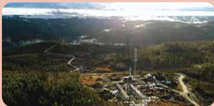
Vue des travaux
