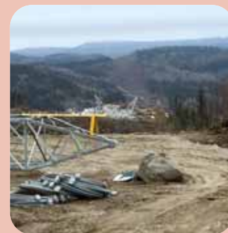
Vue des travaux
