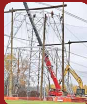
Structure de bois temporaire pour supporter les conducteurs
