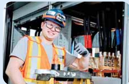
Chantier : Vantage. Entrepreneur : Revenco. Travailleur : Philippe Galant. Représentant : Dave Larocque.
