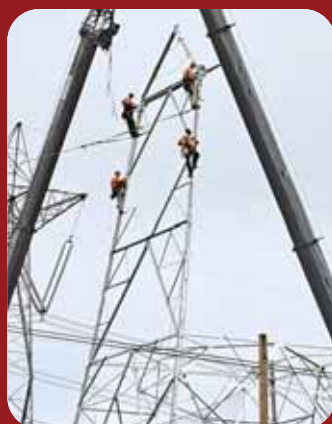
Érection de tours, pylône # 16
