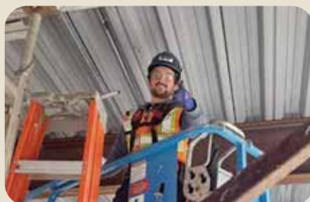
Le confrère Alexandre Dupont-Corbin, au chantier de la nouvelle École Lab de Rimouski. Entrepreneur : RPF électrique. Représentant : Marc Pelletier.
